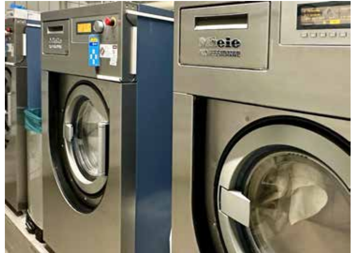
Blick in die Wäscherei des Egon-Reinert-Hauses
